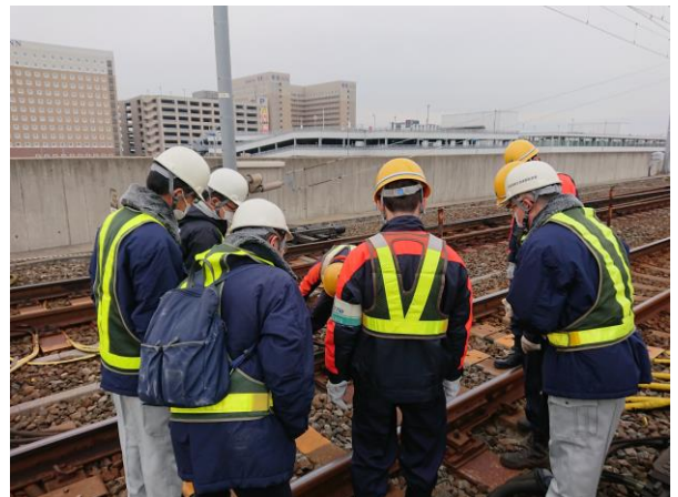
2023年12月 空港線施設巡視
