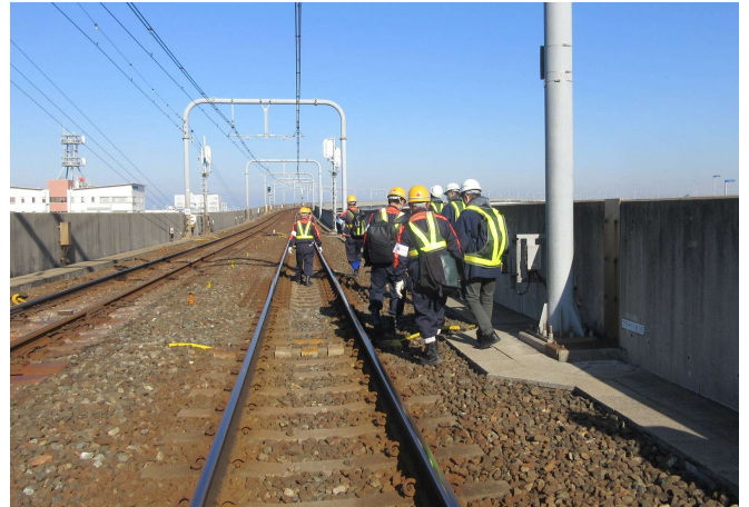
2024年12月 空港線施設合同巡視
