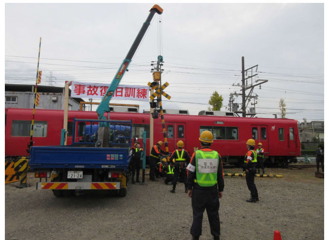
2025年11月 災害事故総合復旧訓練
