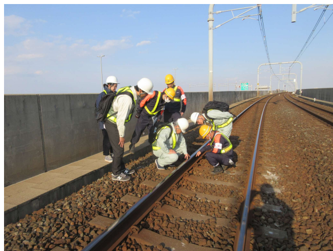
2025年12月 空港線施設合同巡視
